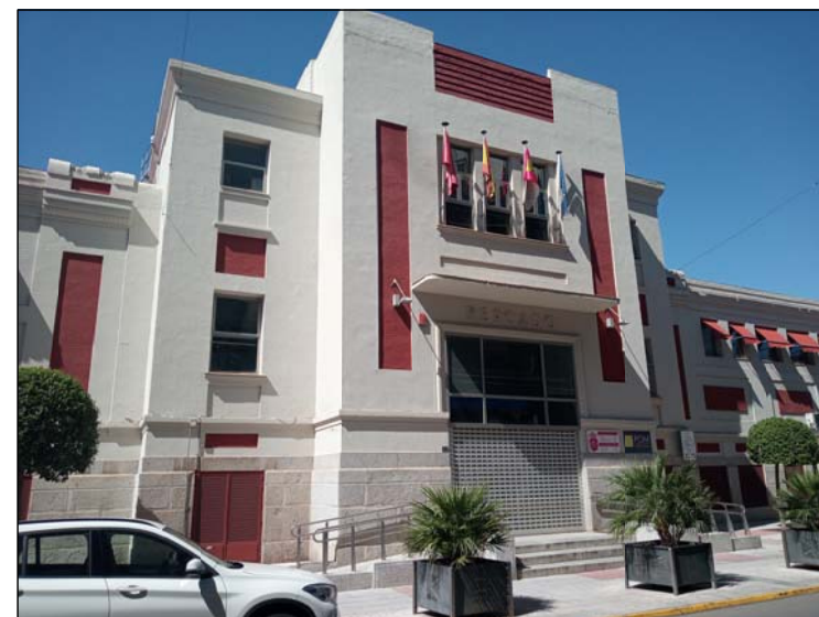
Vista fachada principal. C/ Postas entrada al edificio
