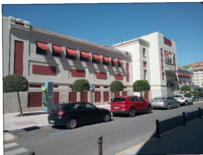
Vista fachada principal. C/ Postas
